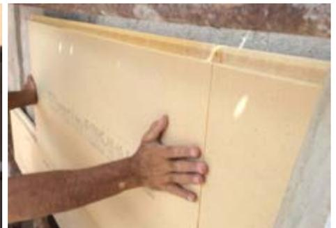
I pannelli **Fibertherm® protect/ Fibertherm® protect dry** possono essere ancorati al substrato in legno con graffette in acciaio inossidabile o tasselli ad espansione.
